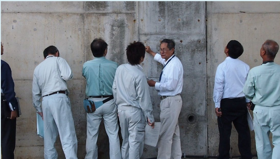
橋台コンクリートの漏水部の劣化現地研修 (平成25年10月12日) 広島県安芸高田市
