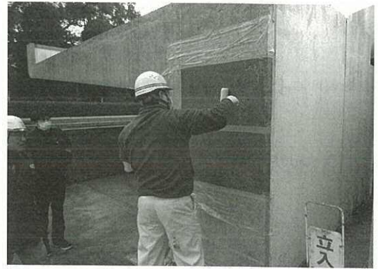
写真4 表面含浸材による補修試験
