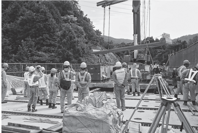
PC床版の架設状況を見学する参加者
