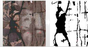
ひび割れ部を2値化処理により抽出
