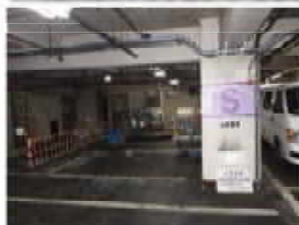
施工箇所全景
