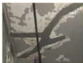
漏水補修施工直後
