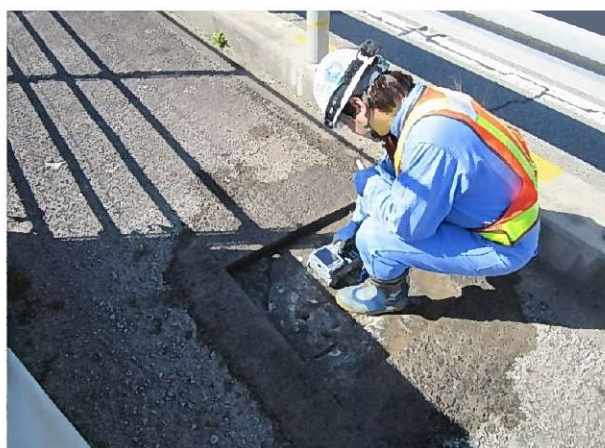
鉄筋探査計による計測画面例と計測状況
