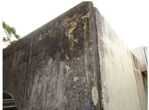
北面東柱(上部)
