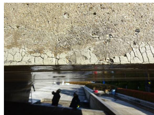
写真-4 洗浄後のコンクリート面の状況
