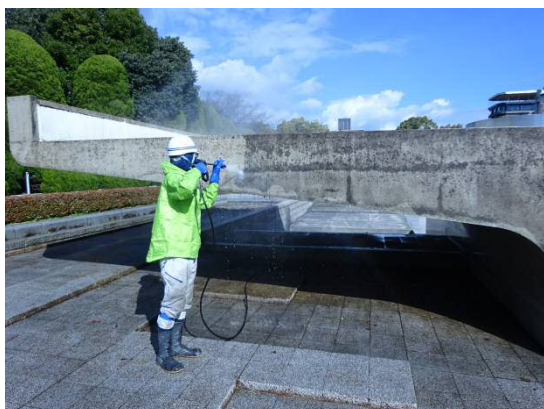
南面の洗浄状況1
