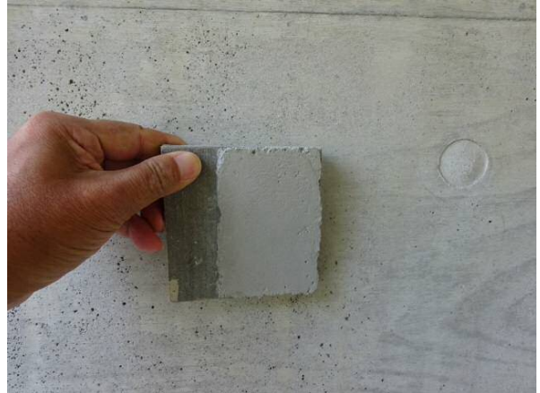
断面修復材との色調比較(西壁面)
