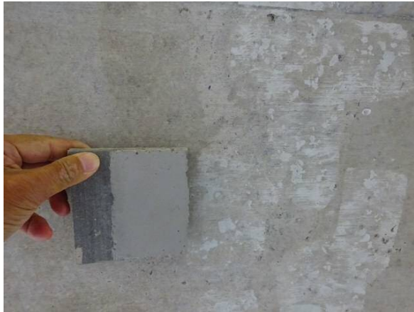
断面修復材との色調比較(西壁面)
