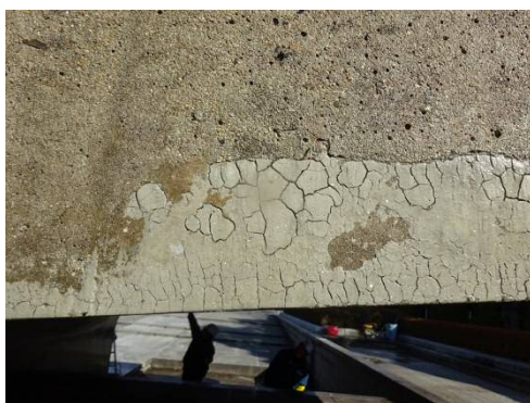
写真-4 洗浄後のコンクリート面の状況
