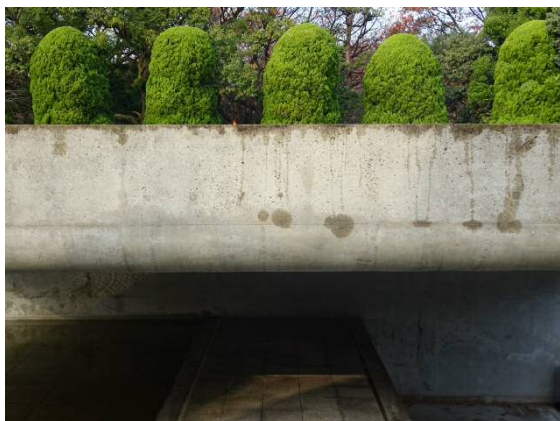
東立上り外面(中間)
