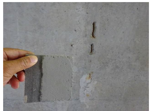
断面修復材との色調比較(西下面)
