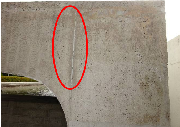
型枠目地部の段差は平滑に切削除去
