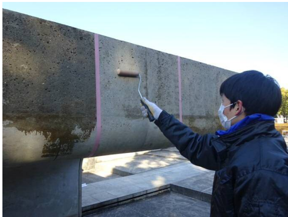
亜硝酸リチウムの塗布状況
