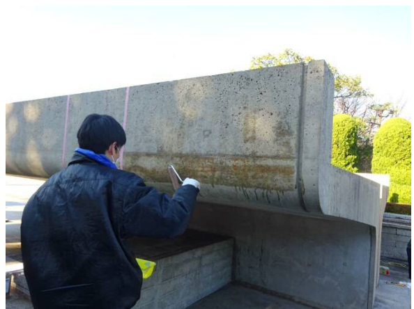
ケイ酸塩系表面含浸材の塗布状況
