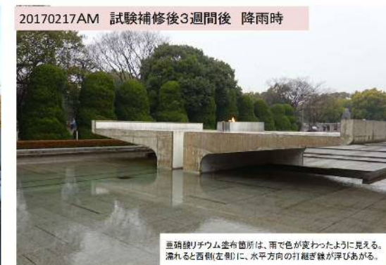
試験補修後3週間 (洗浄後23日後)
