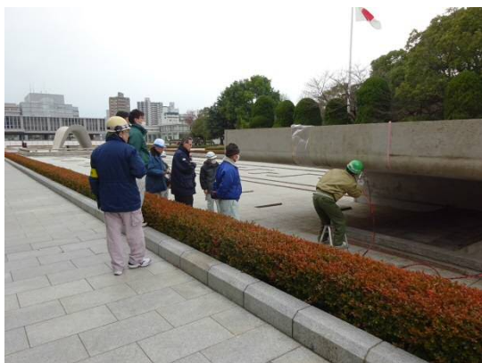
酸化チタンコートの吹付状況
