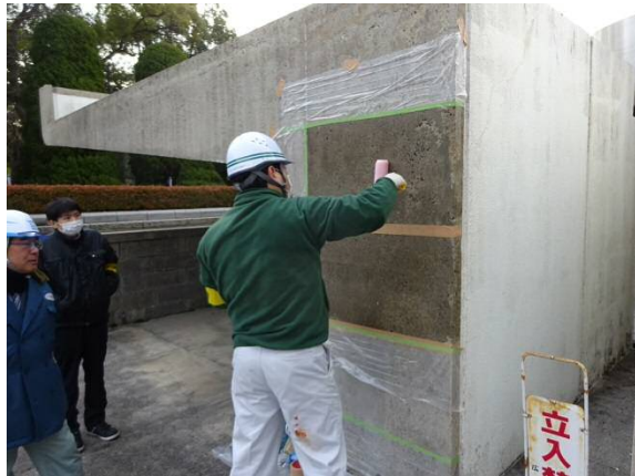
シラン系含浸材の塗布状況
