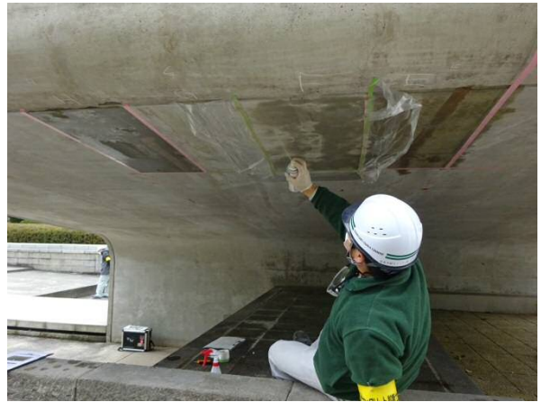
ボカシ剤の吹付状況
