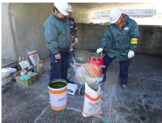
薄層断面修復材の練混ぜ状況
