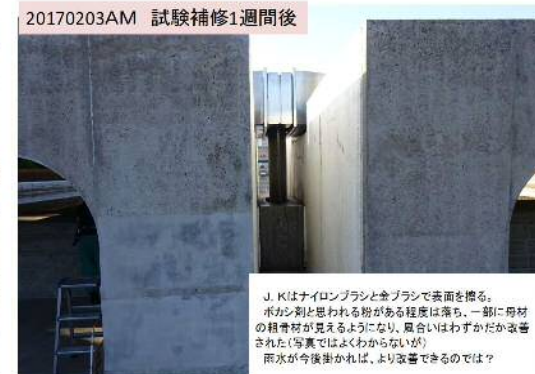
試験補修後1週間（洗浄後9日後）
