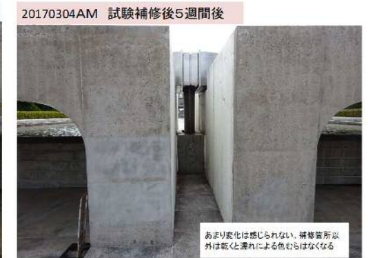
試験補修後5週間（洗浄後38日後）
