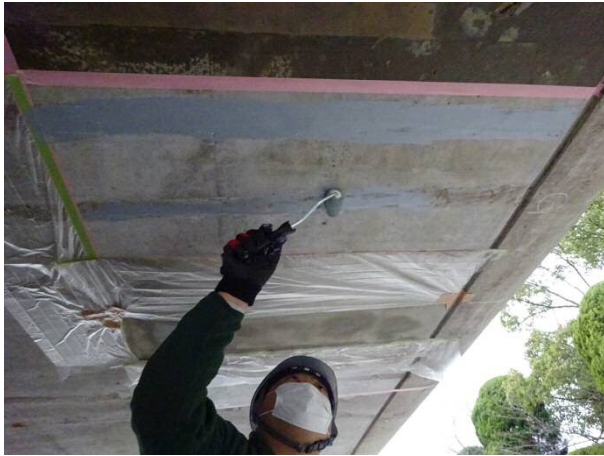
断面修復部へのエポキシ塗料塗布状況
