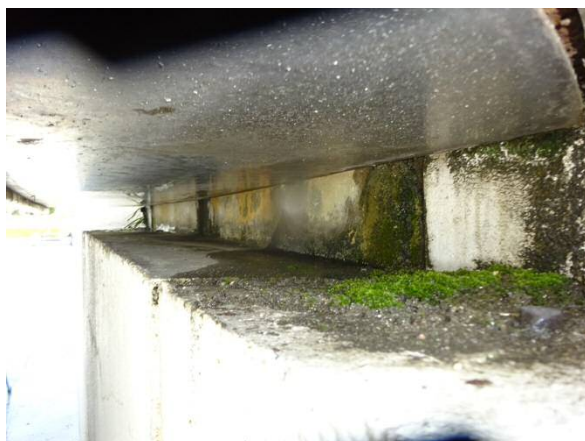
灯火周りの堆積土砂は今回作業中に清掃する
