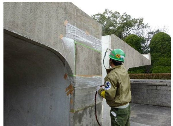
酸化チタンコートの吹付状況
