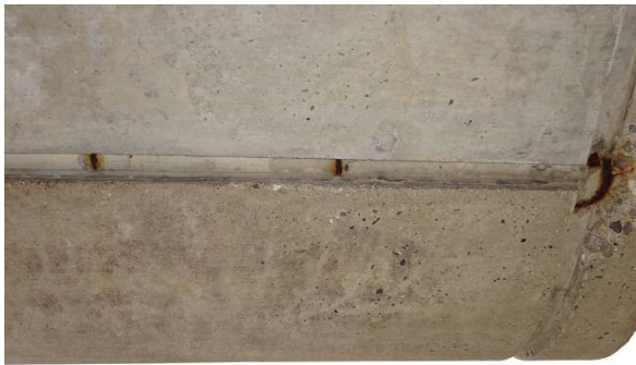
型枠目地部の段差は平滑に切削除去
