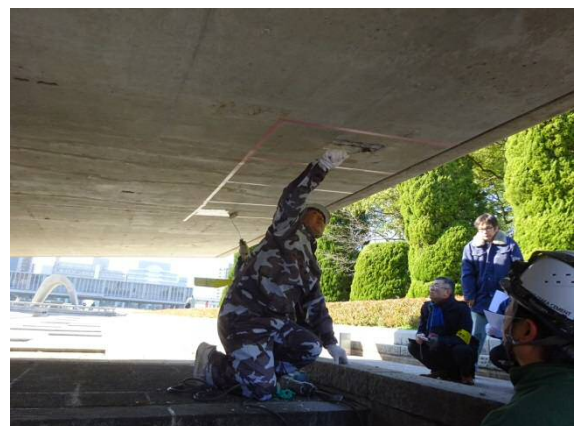
薄層断面修復材の左官塗りつけ状況
