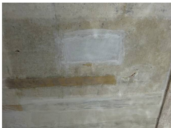
このような補修箇所の茶色変色は修正する
