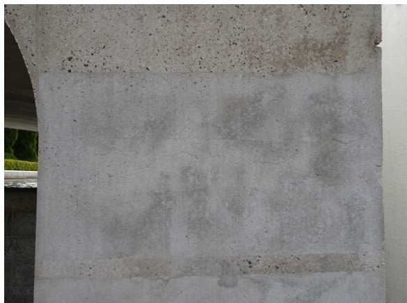
北面のボカシ剤を箇所はサンダーなどで薄く削る
