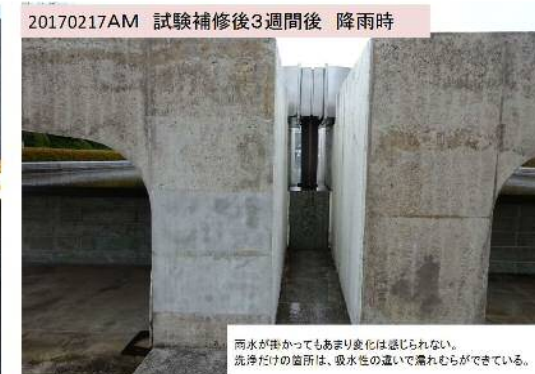
試験補修後3週間（洗浄後23日後）
