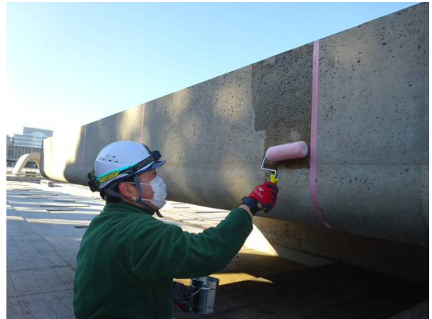
シラン系表面含浸材の塗布状況
