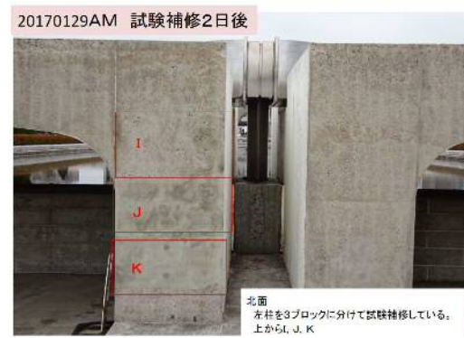
試験補修2日後（洗浄後4日後）
