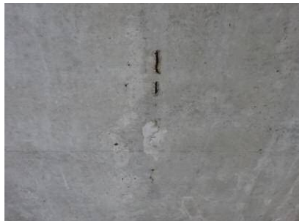
このような鉄筋露出ははつりを最小限にとどめる
