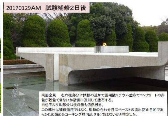
試験補修2日後 (洗浄後4日後)
