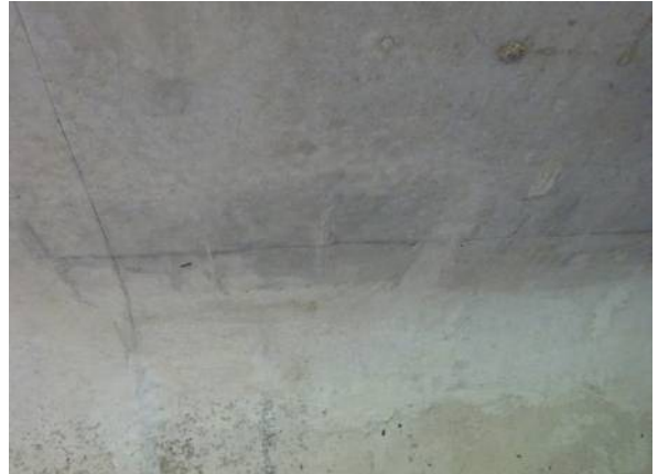
防錆処理後、表面外観修正
