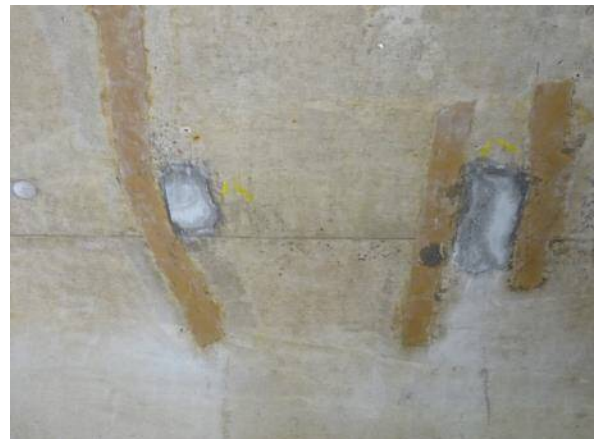
断面修復補修後
