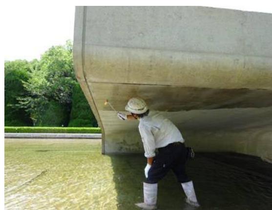
ケイ酸塩系表面含浸材の塗布
