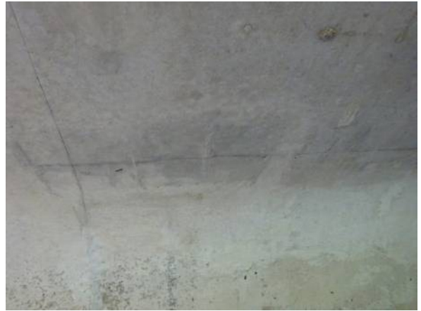
防錆処理後、表面外観修正
