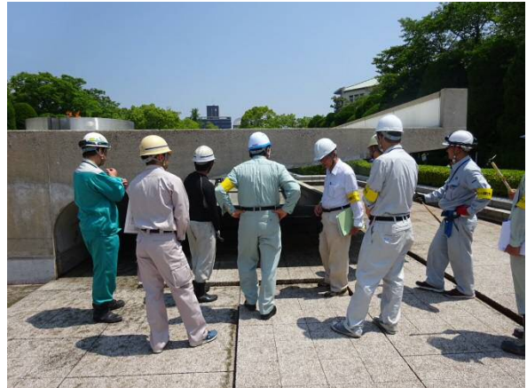
南面の補修法確認
