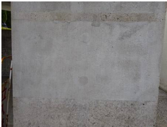
北面:補修試験でのボカシ剤使用箇所
