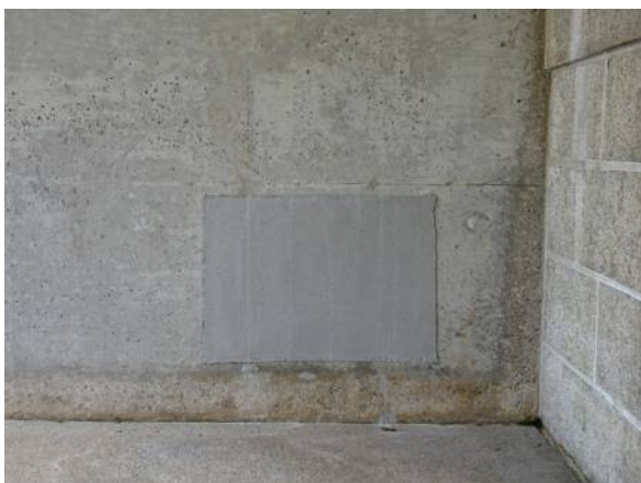
西壁面:薄層断面修復の試験箇所
