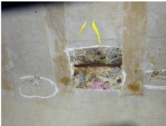
断面修復箇所のはつり出し
