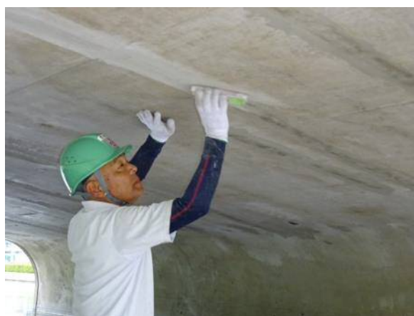
下地処理剤の研磨状況
