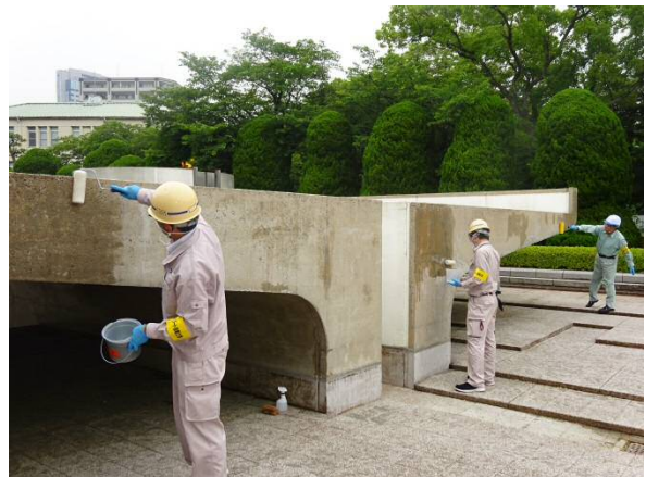
会員による含浸材塗布状況
