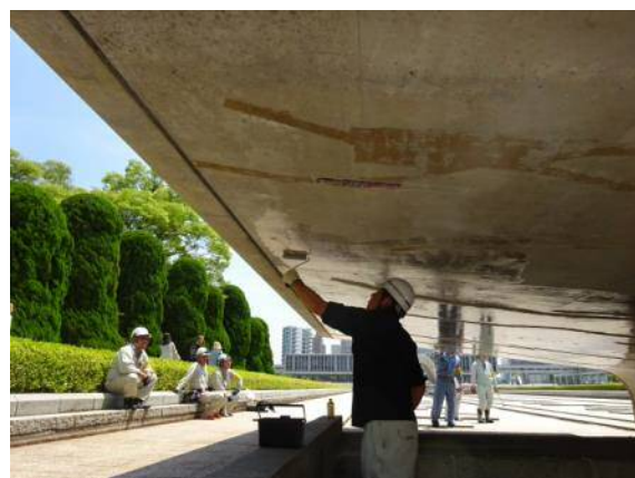
亜硝酸リチウムの塗布
