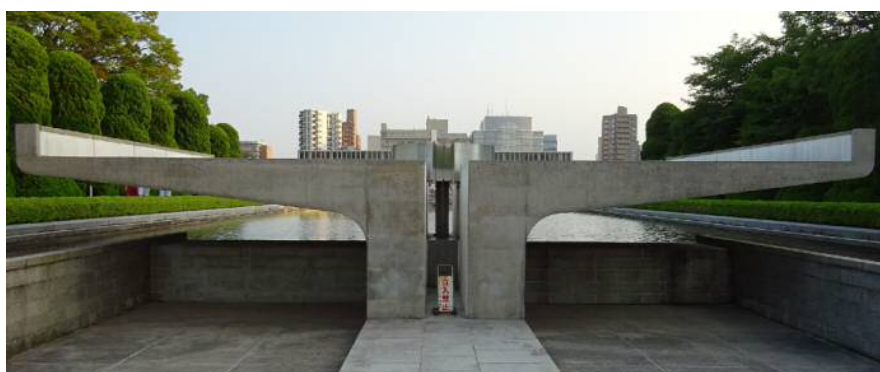
北面:補修後 2017 年 7 月
