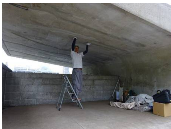
断面修復箇所への下処理剤塗布
