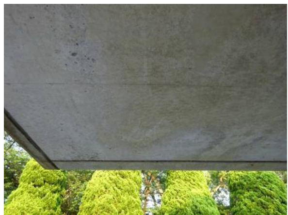
はつり調査、断面修復、表面外観修正
