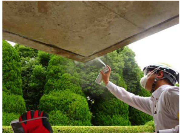
防錆処理後、ボカシ剤処理
