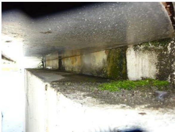
灯火近傍の堆積土砂
