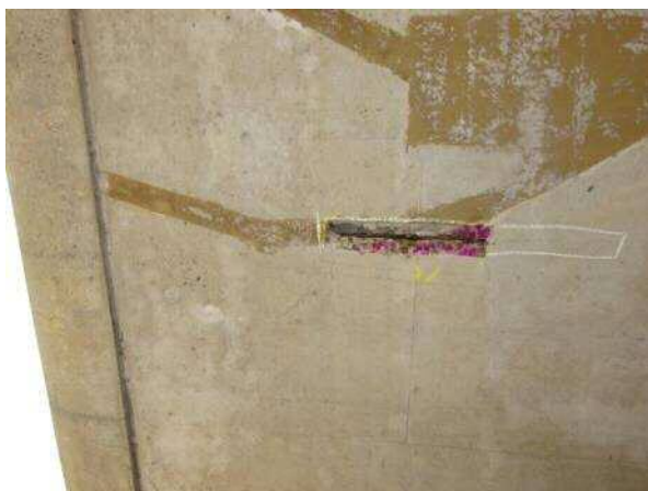
浮き箇所のはつり状況
