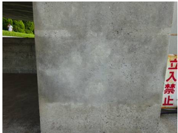
サンダーで研磨後、含浸材塗布
