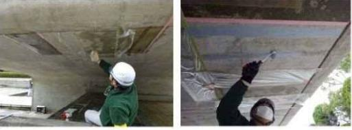
断面修復部へのエポキシ塗料塗布状況      ボカシ剤吹き付け状況
