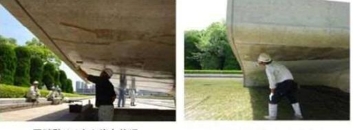
亜硝酸リチウム塗布状況      ケイ酸系表面含浸剤の塗布状況
