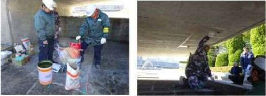
薄層断面修復材の練混ぜ状況      薄層断面修復材の左官塗りつけ状況
