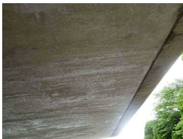
点検後(2018年6月7日) 断面修復材を出す懸念から清掃を見送っている
