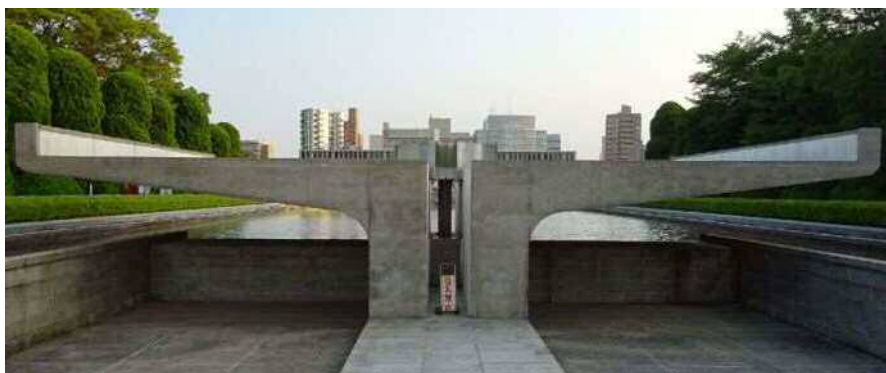
北面:補修後 2017 年 7 月
