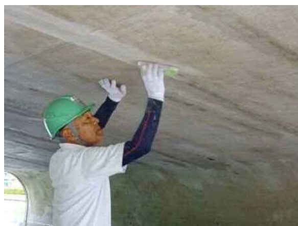
断面修復箇所の外観修正作業
