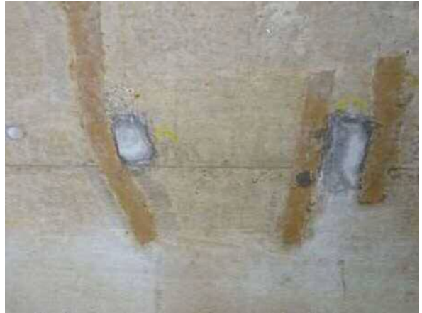
断面修復補修後
