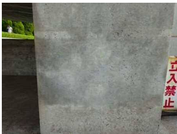
サンダーで研磨後、含浸材塗布
