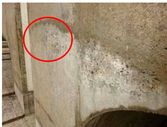
白色モルタルの切削除去
