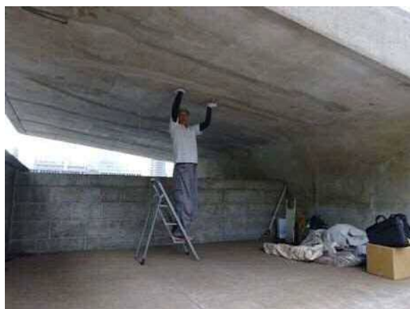
断面修復箇所の外観修正作業
