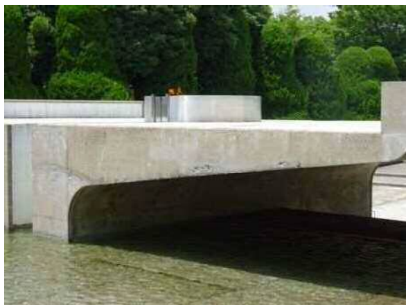
白色モルタルの切削除去
