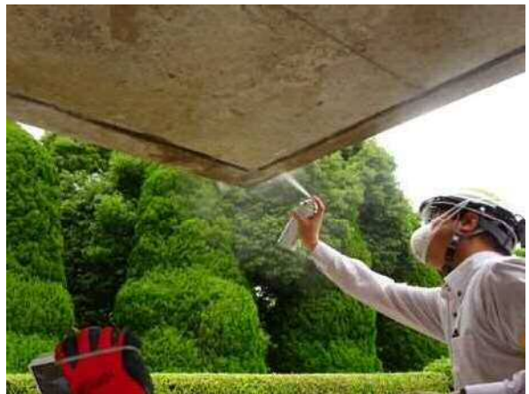
防錆処理後、ボカシ剤処理
