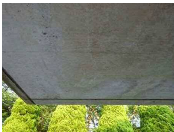
断面修復、表面外観修正
