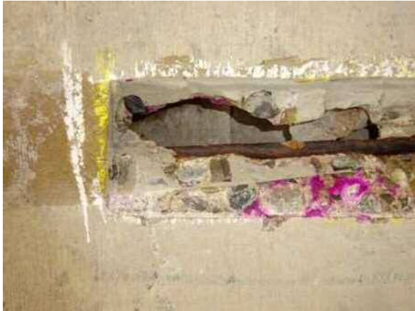
下面既存補修箇所での鉄筋露出(内部に空洞)
