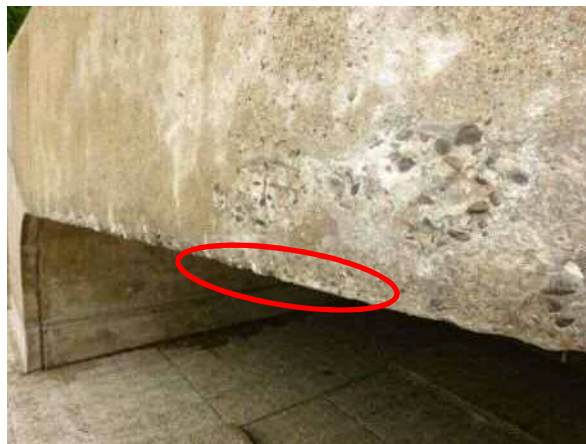
白色モルタルの切削除去
