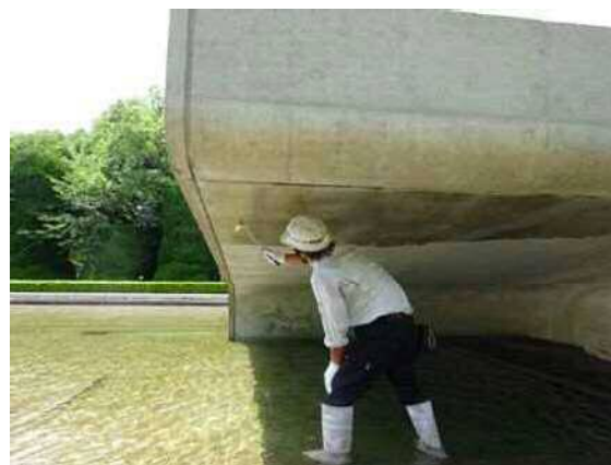
ケイ酸塩系表面含浸材の塗布
