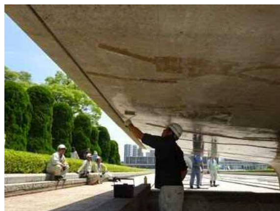
亜硝酸リチウムの塗布
