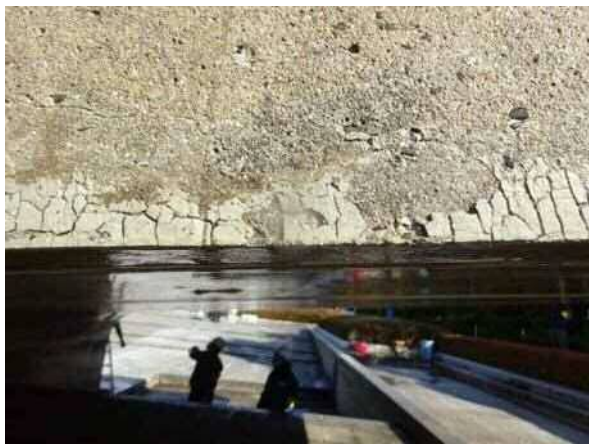
南面:白色モルタルの付着
