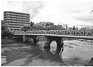
建築鉄骨再利用で架けられた本川橋
