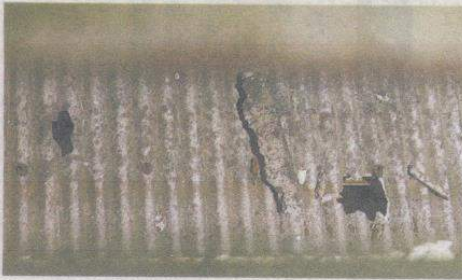
マツタの倉庫の屋根に落ちた コンクリート片(中央)と2 カ所の穴
