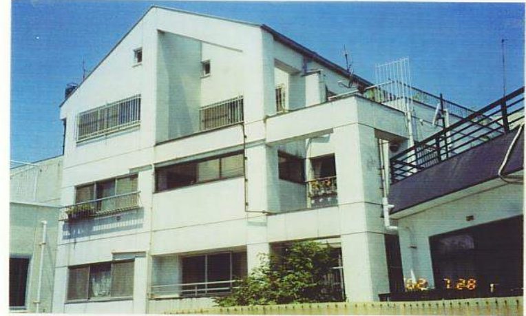
高強度コンクリート(50N/mm 2 )の建物
