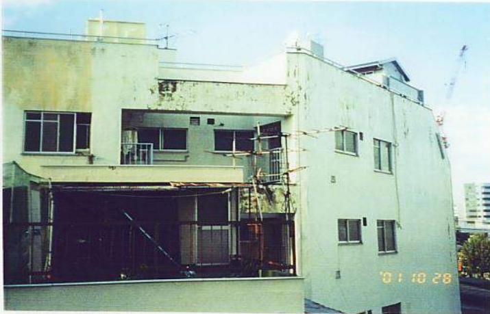
品質の悪いコンクリートの建物
