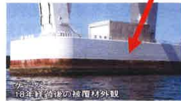
ケーソン上部に施工 18年経過後の被覆外観
