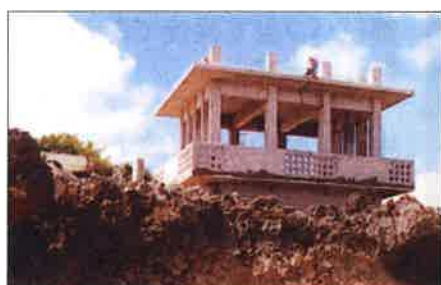
沖縄備瀬暴露試験場 / 塩害 / 琉球大学
