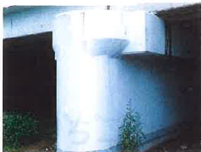
アルカリ目材反応の被害を受けた柱に効果的とする施工事例(1) *施工後約8年経過、特に劣化なく良好な状態。
