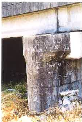
アルカリ目材反応の被害を受けた柱に効果的とする施工事例(1) *施工後約8年経過、特に劣化なく良好な状態。
