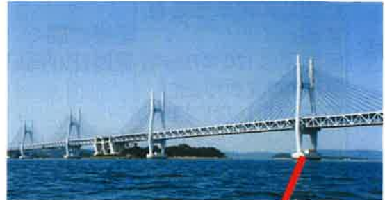
岩黒島橋、櫃石島橋のケーソン部
