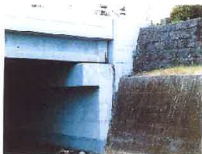
アルカリ目材反応の被害を受けた柱に効果的とする施工事例(1) *施工後約8年経過、特に劣化なく良好な状態。
