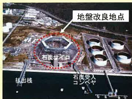
下松石炭中継基地(建設時)
