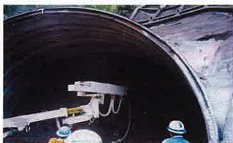
EPショット(トンネル吹付)
