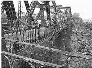
支柱とトラス桁で支持されている状況
