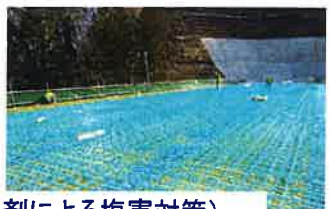
橋梁床版(凍結防止剤による塩害対策)
