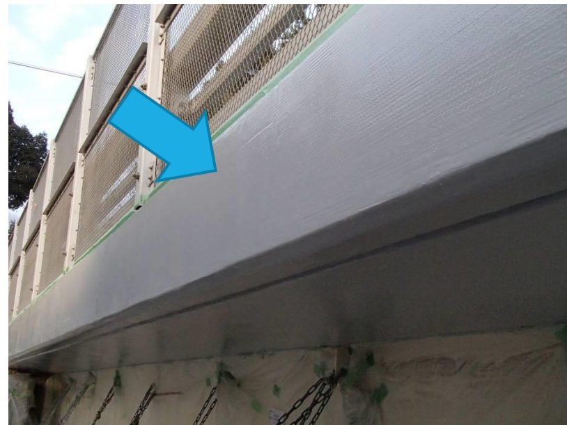
ネットキーパー工法
