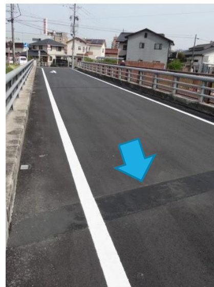
伸縮装置(埋設・鋼製)
