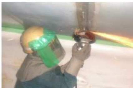
写真-4.2.8 グラインダ作業の例
