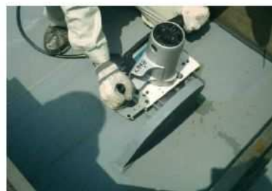
写真-4.2.9 吊金具切断機の例
