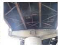
写真7 足場の撤去完了状況
