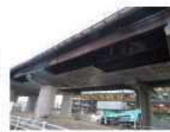
写真6 足場の撤去状況
