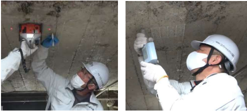
橋梁点検・詳細調査
