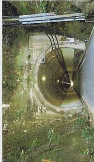
＜仁方隧道の状況＞
