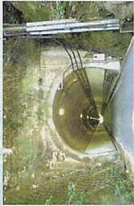
<仁方隧道の状況>
