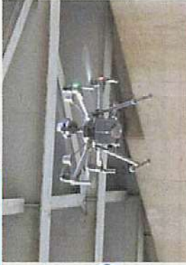
(新技術：ドローンによる点検)
